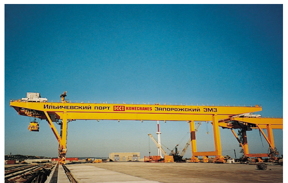
Кабельные барабаны Cavotec и система защиты кабеля Panzerbelt® в порту Ильичёвска на Чёрном море.
