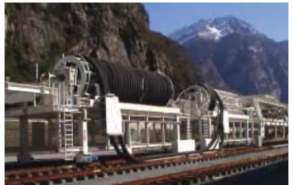
Гигантские барабаны для строительства тоннеля San Gotthard, Швейцария.
