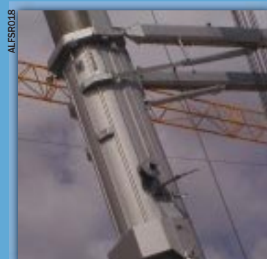
На подвижном кране LIEBHERR.
