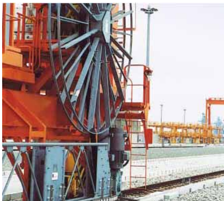
Контейнерный терминал Кавасаки, Япония
